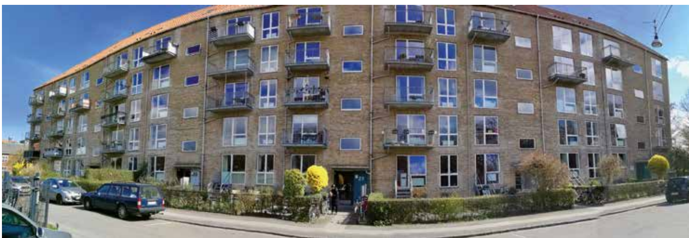
266 lejligheder i Sjællandshuse, Kgs. Enghave, København, fik nye vinduer og franske altaner. En stor udvendig altan kunne tilvælges efter eget ønske.
