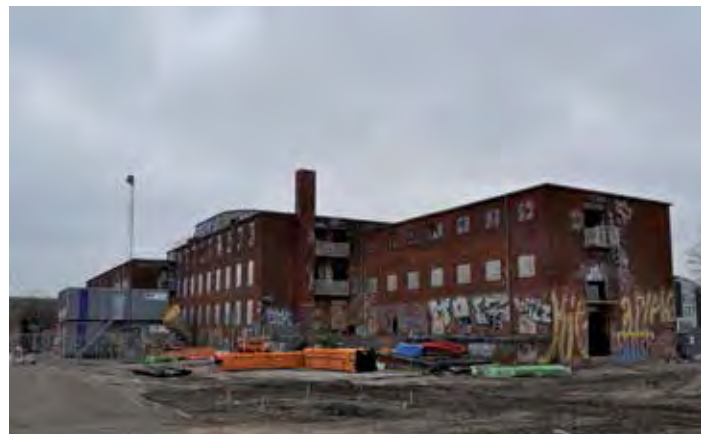
Inden renoveringen lå Konstabelskolen hen som ruin, men var erklæret bevaringsværdig. Det stillede en række krav til renoveringen.
