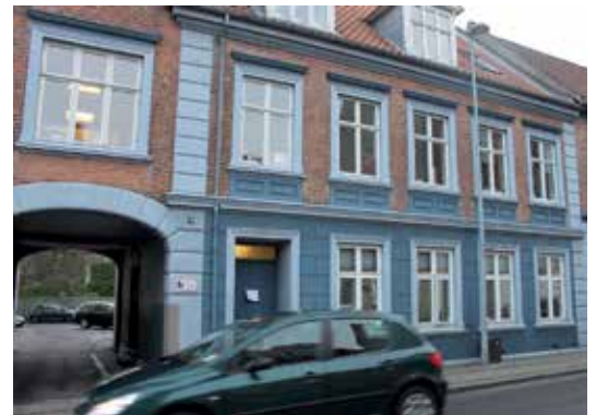
Bag de fire vinduer i gadeplan er LLO nu flyttet ind.
