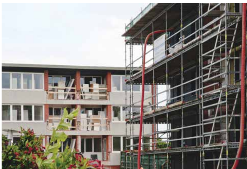
Facaderenovering i Brønderslev. (Arkivfoto: Landsbyggefonden)
