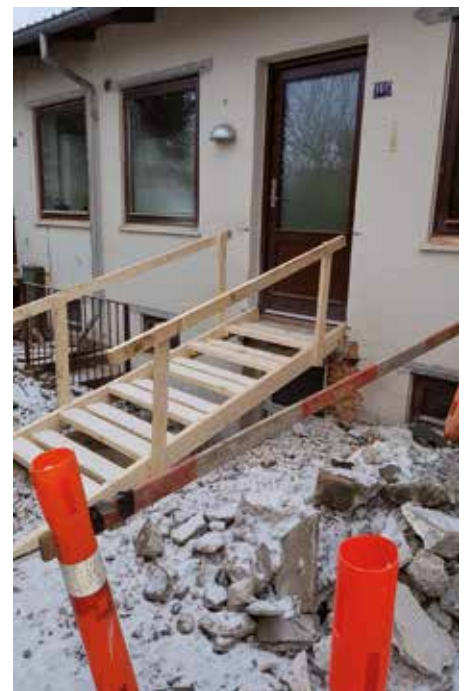
De 66 små rækkehuse er fra 1940'erne (Foto: James Arbøl).
