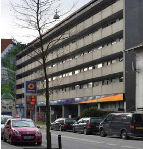
Sådan så etageejendommen fra 1968 ud før renoveringen... ..og i dag.
