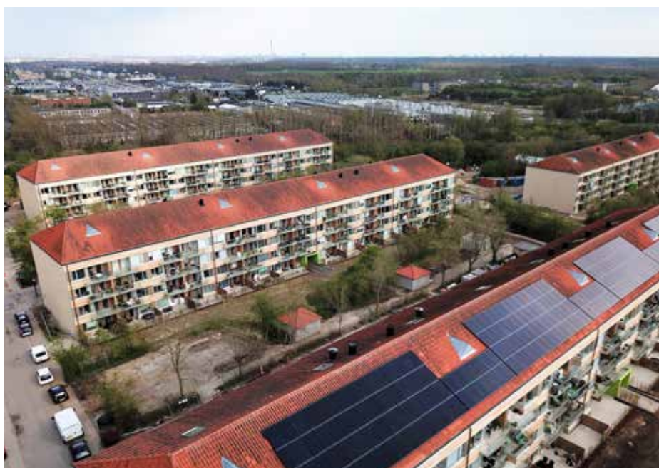
Korngården er oprindelig opført i 1958 og består af fire blokke. Solcelleanlægget på taget dækker merforbruget til ventilationssystemet samt elforbruget i opgang og udearealer. (Dronefoto: Bo Bjerre Hansen)
