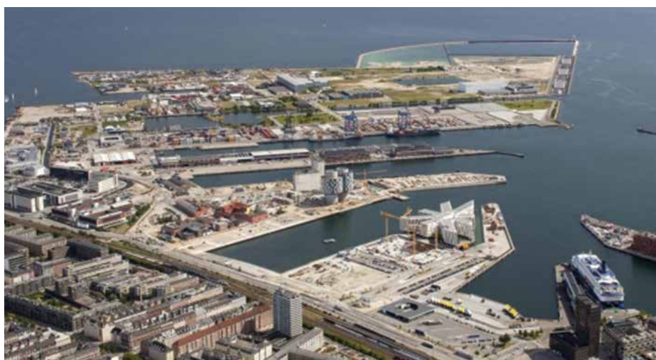
Øverste halvdel af dette billede er Københavns nye, attraktive bydel 2150 Nordhavn. I den gamle industrihavn er der planlagt 40.000 boliger. Det bliver overvejende ejerboliger. Men bl.a. KAB står på spring for at bygge almene boliger.
