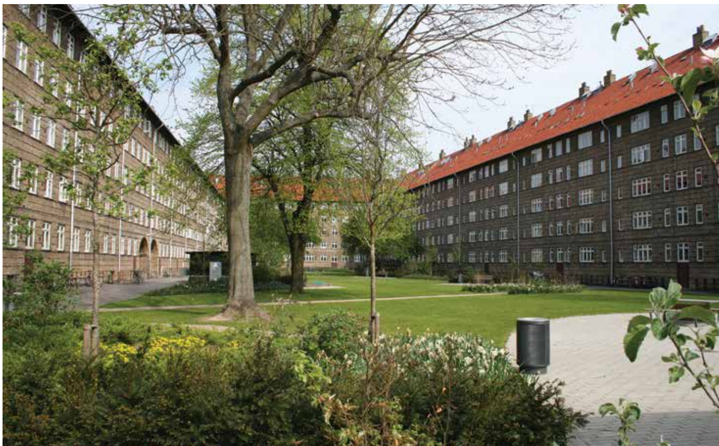
Udgifterne til renholdelse løber hurtigere end den almindelige prisudvikling i både den almene og den private boligsektor. Og udgiften til administration stiger fra 1. januar 2016. (arkivfoto).
